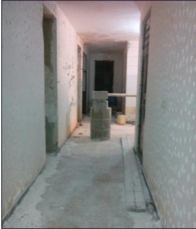
تصاویر بازسازی ساختمان بسیج خیرگو- ۲۳ مرداد ۹۴
